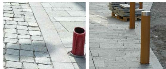
ESEMPIO DI POSA PREVIO CAROTTAGGIO A PAVIMENTAZIONE ESEGUITA
